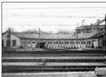
Avenue du Midi, gare de Fribourg, rotondes des locomotives CFF (détruite en avril 1991), 1990.
