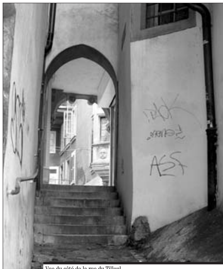
Vue du côté de la rue du Tilleul.
