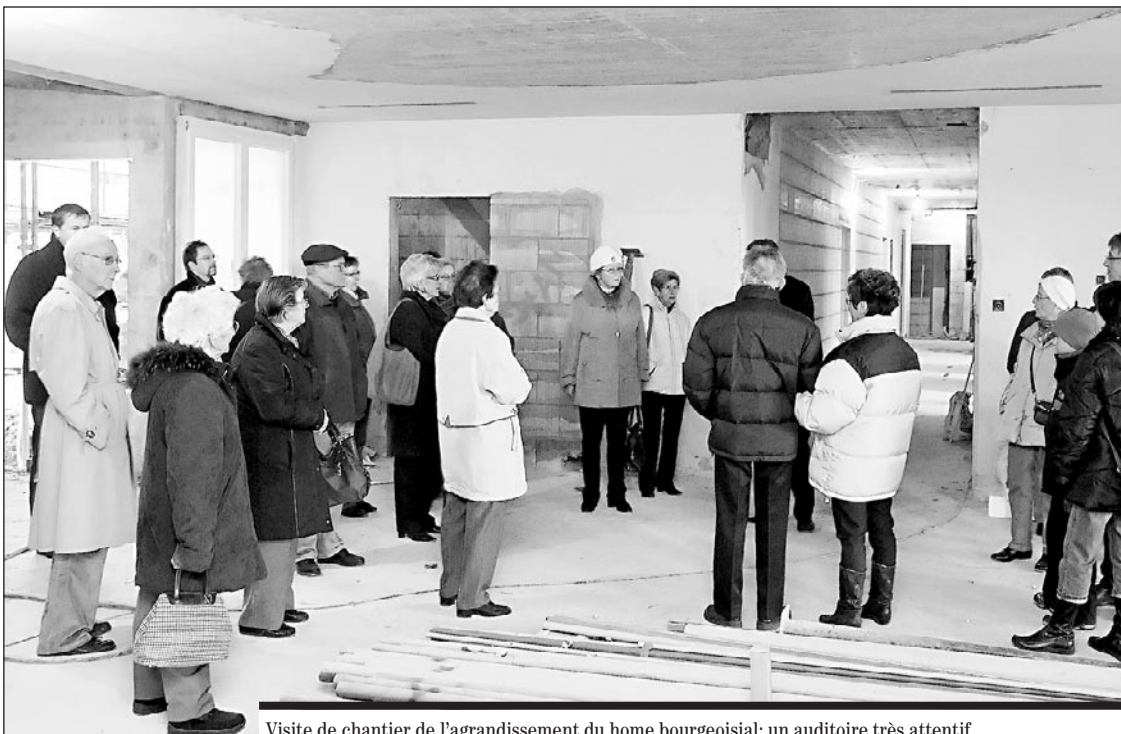
Visite de chantier de l'agrandissement du home bourgeoisial: un auditoire très attentif.
