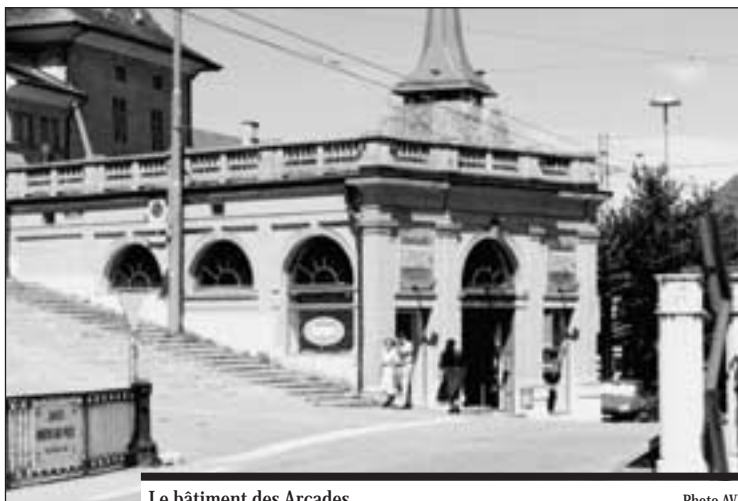
Le bâtiment des Arcades
