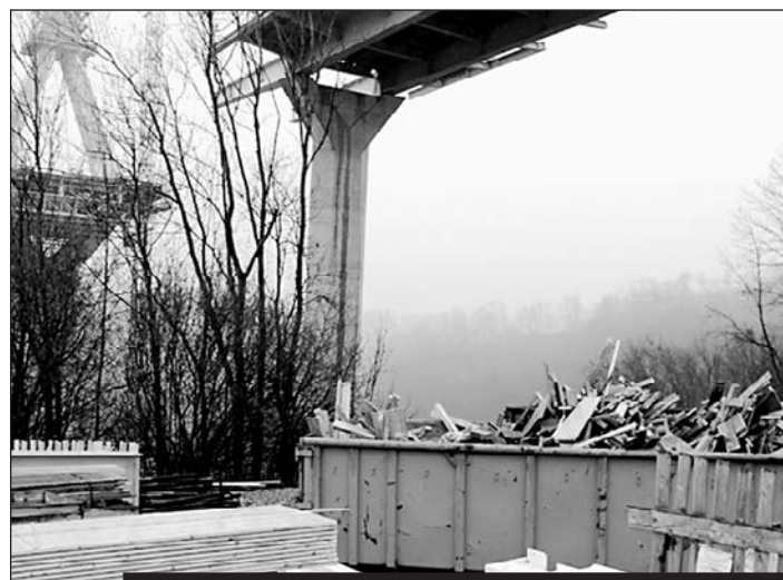
Tri des déchets sur le chantier du Pont de la Poya. Abfalltrennung auf der Baustelle der Poyabrücke.
