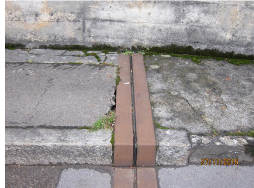
N°14 JOINT DE CHAUSSÉE RIVE DROITE /CÔTÉ VILLE / PARTIE SUR TROTTOIR
