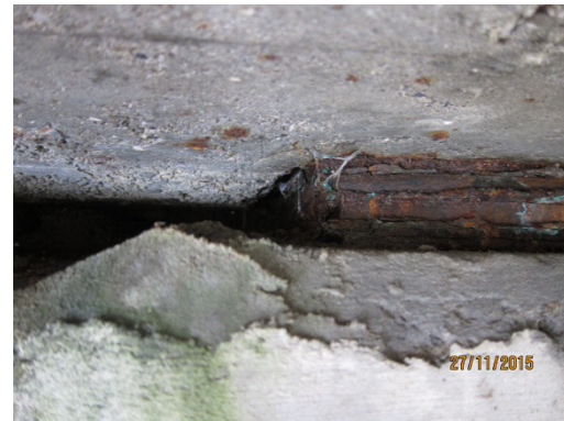
N°8 CULEE RG/ APPAREIL D'APPUI ECRASEMENT
