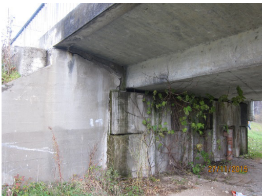
N°3 CULEE RG/ VUE D'ENSEMBLE
