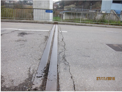
N°13 JOINT DE CHAUSSÉE AVAL CÔTÉ STEP
