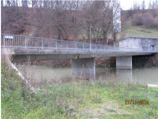
N°1 VUE GENERALE AMONT
