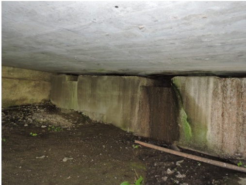
N°15 CULÉE COTÉ VILLE / VENUE D'EAU
