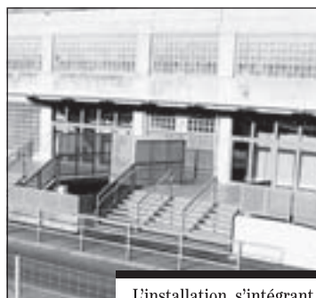
L'installation, s'intégrant très bien dans le cadre du bâtiment, prête à recevoir les spectateurs.
