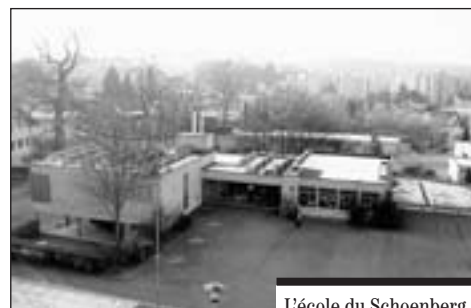
L'école du Schoenberg, un bâtiment sous contrôle énergétique.
