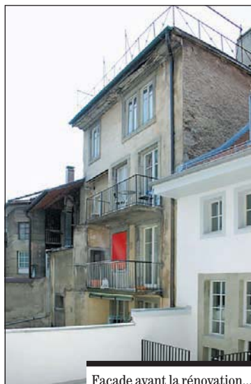
Façade avant la rénovation...
