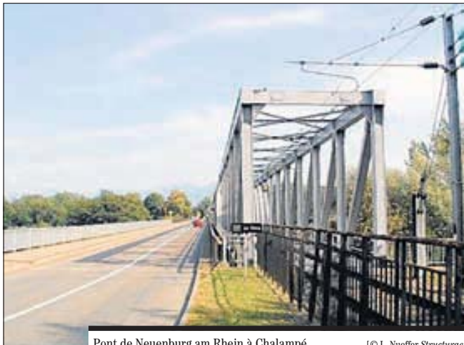
Pont de Neuenburg am Rhein à Chalampé.
