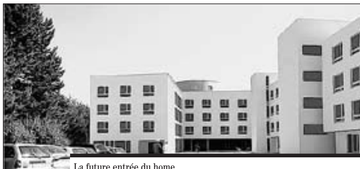
La future entrée du home.
