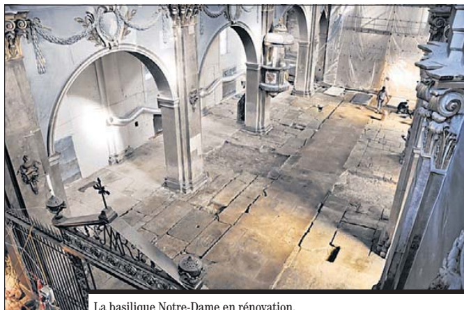
La basilique Notre-Dame en rénovation.
