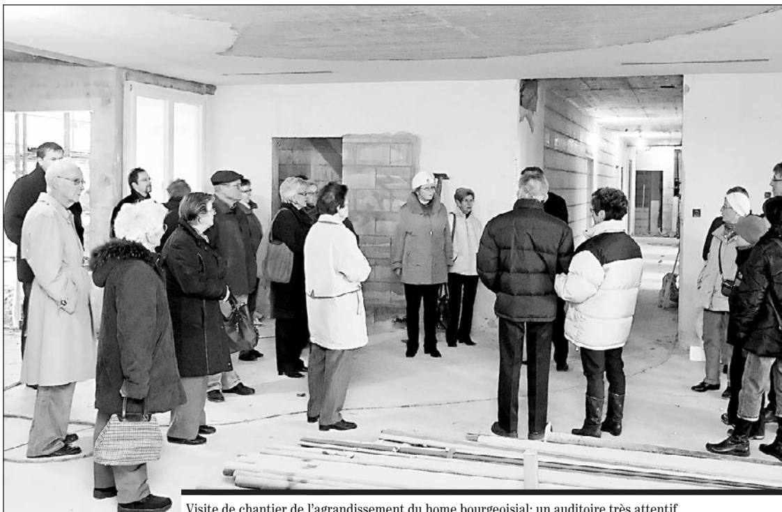
Visite de chantier de l'agrandissement du home bourgeoisial: un auditoire très attentif.
