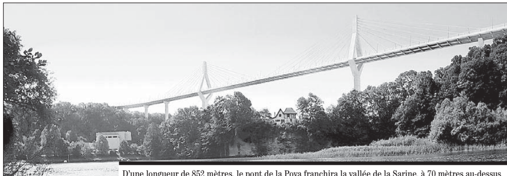
D'une longueur de 852 mètres, le pont de la Poya franchira la vallée de la Sarine, à 70 mètres au-dessus de la STEP. Son mât le plus haut culminera, lui, à 110 mètres au-dessus du sol.
