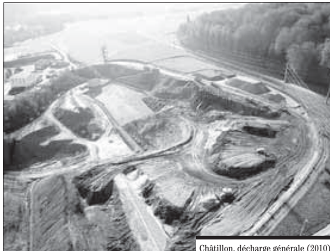
Châtillon, décharge générale (2010).
