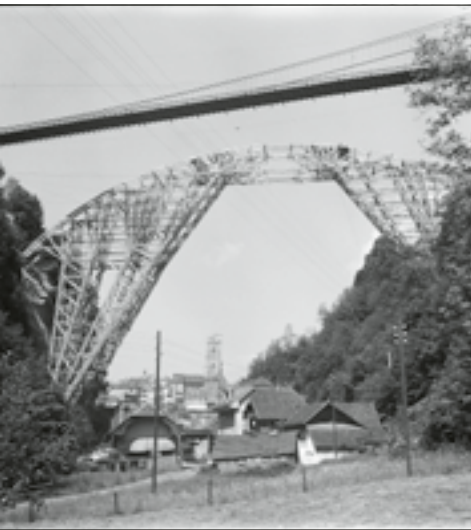
Construction du cintre en bois pour le nouveau pont du Gottéron © Service des biens culturels Fribourg. Fonds Recensement des biens culturels Fribourg
