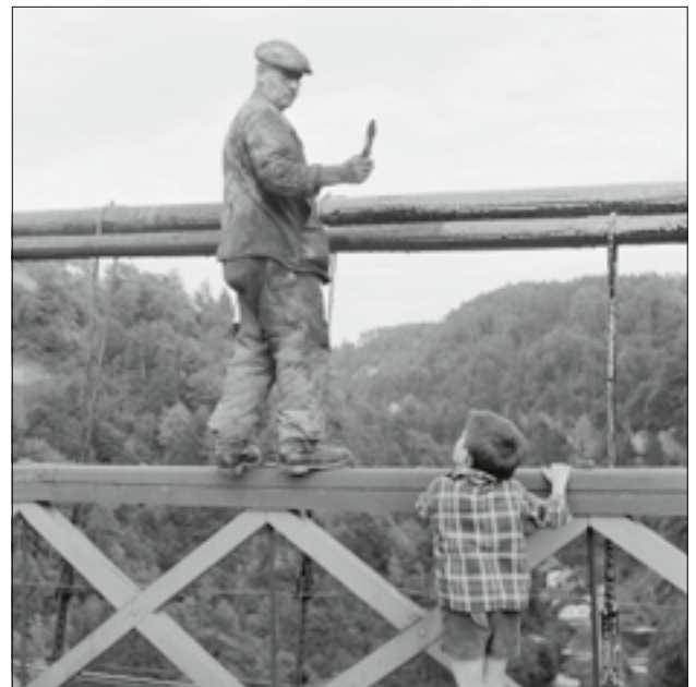
Pont-Suspendu du Gottéron (travaux d'entretien). Fonds Jacques Thévoz © Bibliothèque cantonale et universitaire de Fribourg
