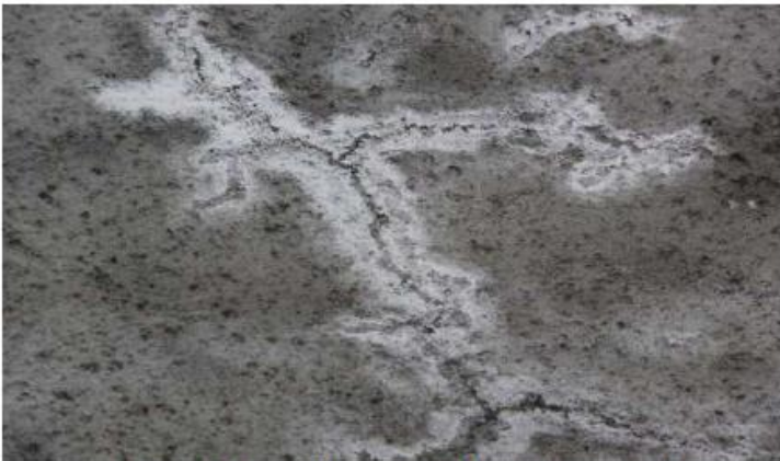
Dépôts salines, taches humides
