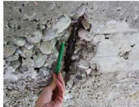
Armatures apparentes
