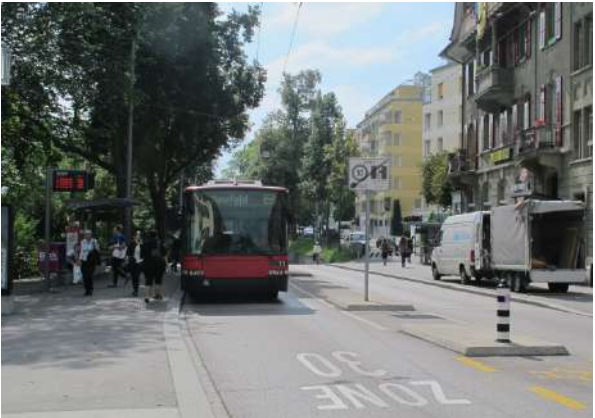
Priorisation du TP sur axe structurant par un arrêt sur chaussée avec impossibilité de dépasser pour le TIM, Neubrückstrasse, Berne
