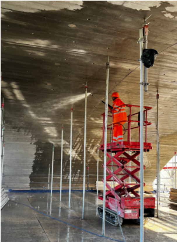
Zähringerbrücke während den Arbeiten
