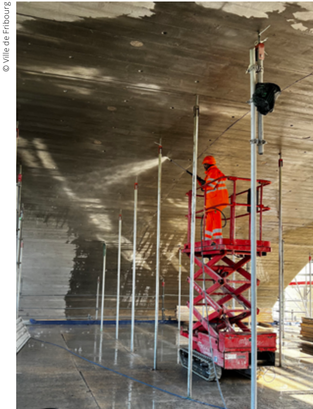
Pont de Zaehringen pendant les travaux
