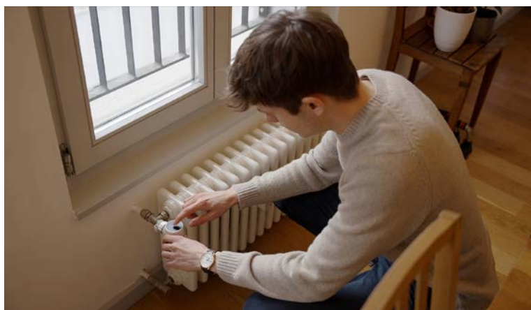
La consommation de chauffage a été réduite en moyenne de plus d'un tiers, notamment grâce aux thermostats intelligents. © By the way studio / Davide Nestola
