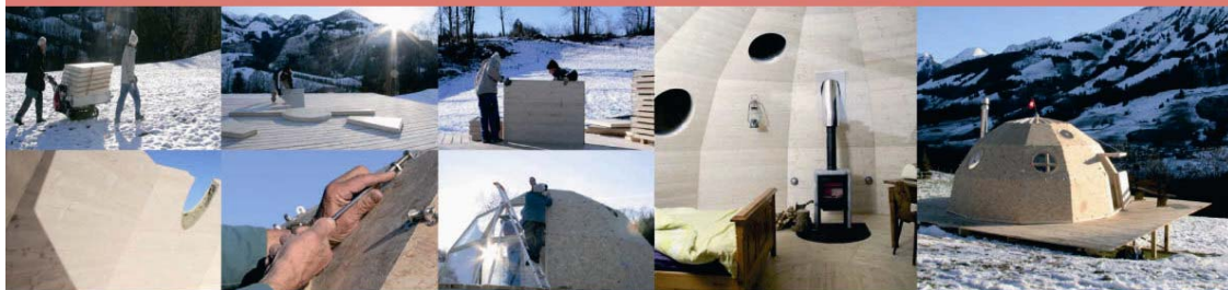
Les étapes d'une construction hors du commun.
